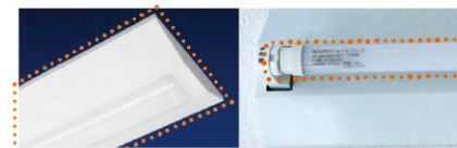
▲器具交換(左)は器具ごと交換するのに対し、管交換(右)は灯具を流用できる。埋め込み型は、アスベスト調査が必要になる場合がある。
