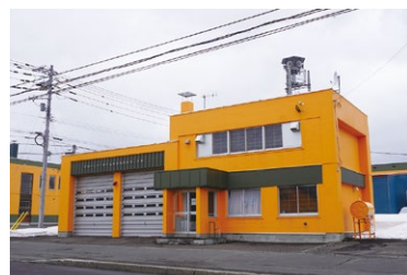
▲上興部地区の消防庁舎分署
