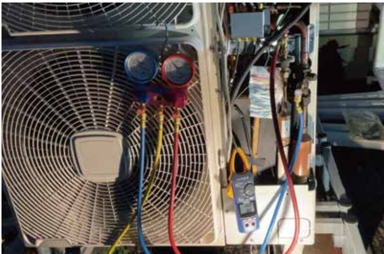
冷媒交換をセッティング
