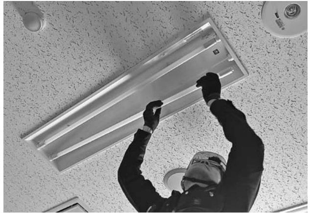
蛍光管型LED照明への交換作業
