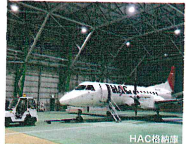
HAC格納庫 水銀灯のLED化で照明の8割以上を削減
